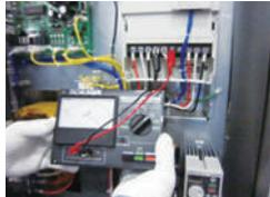
②インバータ静電容量測定
