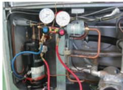
⑤冷媒圧力測定
